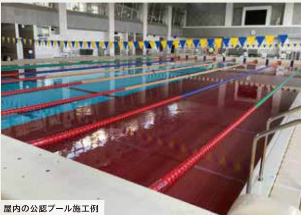
屋内の公認プール施工例
