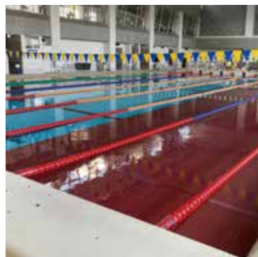
屋内の公認プール施工例
