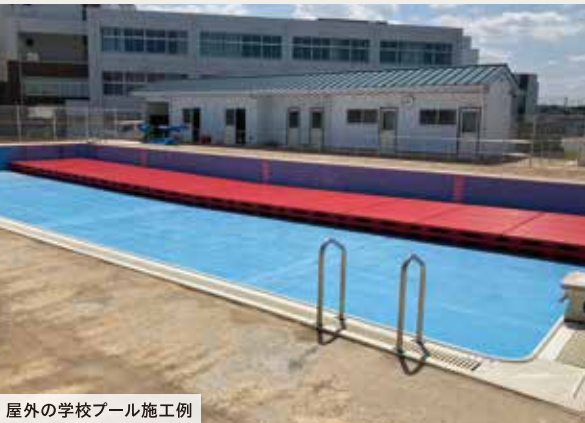
屋外の学校プール施工例
