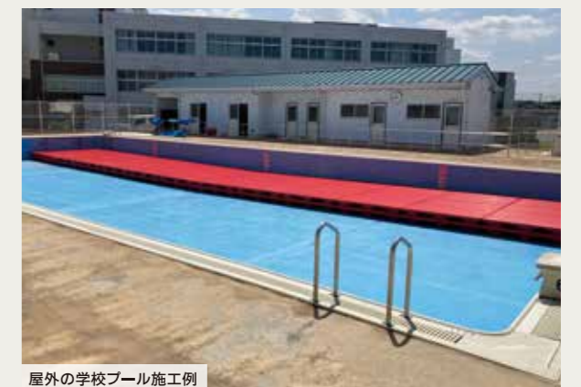
屋外の学校プール施工例
