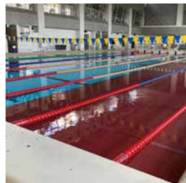
屋内の公認プール施工例
